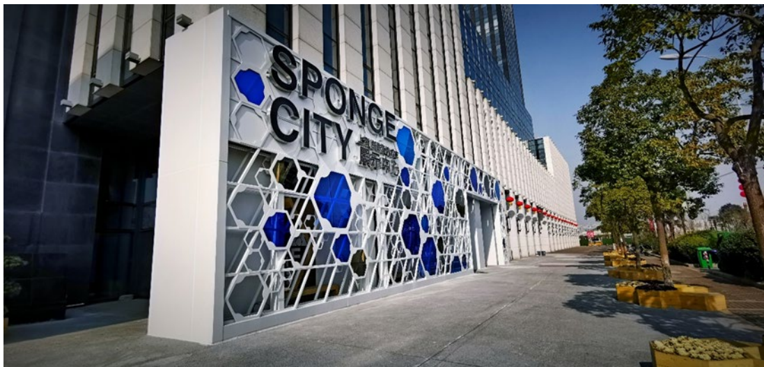
图 25 临港海绵城市展示馆
