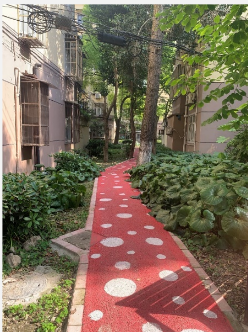
图 34 透水路面改造
