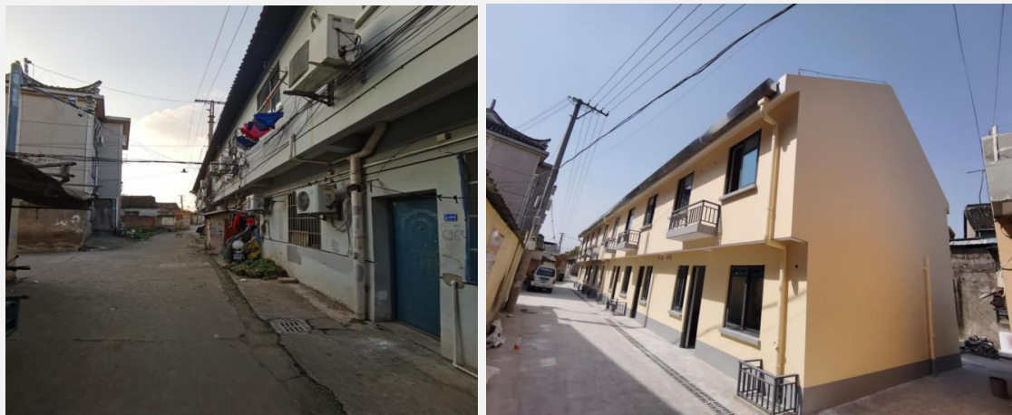
图 39 金汇镇金汇村 696-697 号改造前后
