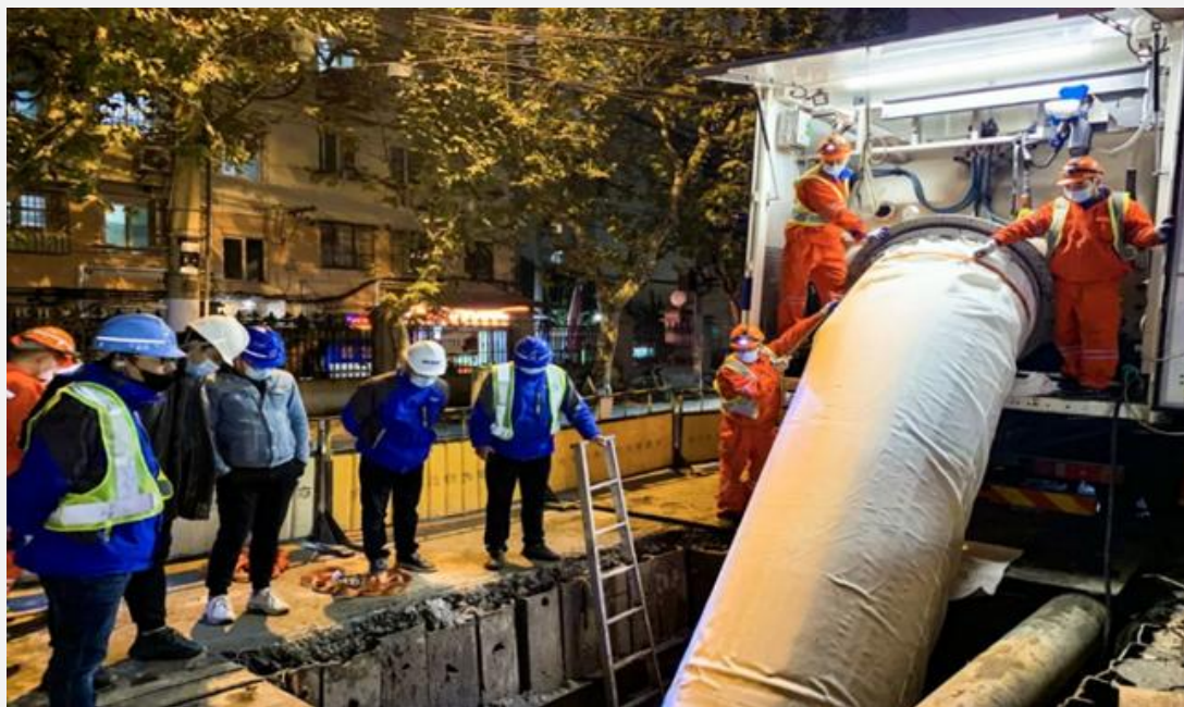
图 14 阜新路项目施工现场
