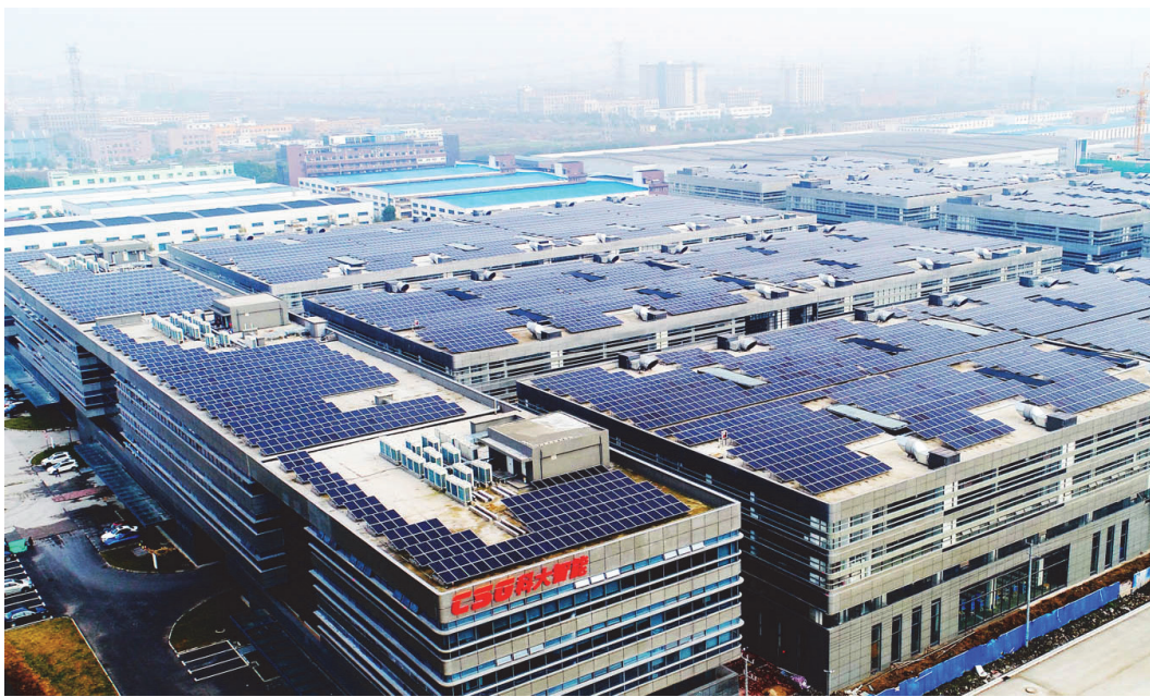
图 14 科大智能机器人产业园中的光伏发电项目
