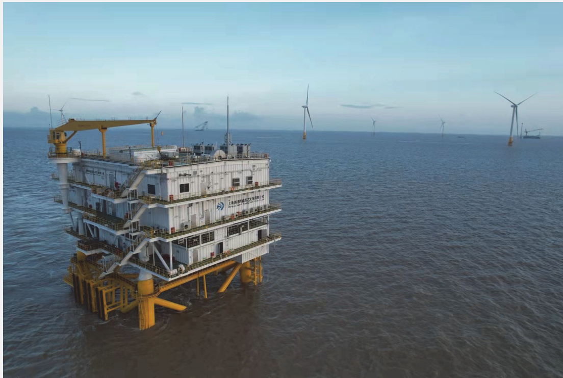
图 14 奉贤海上风电项目海上升压站
