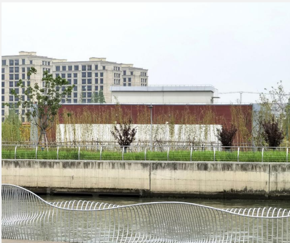
图 30 普陀区云岭西雨水泵站
