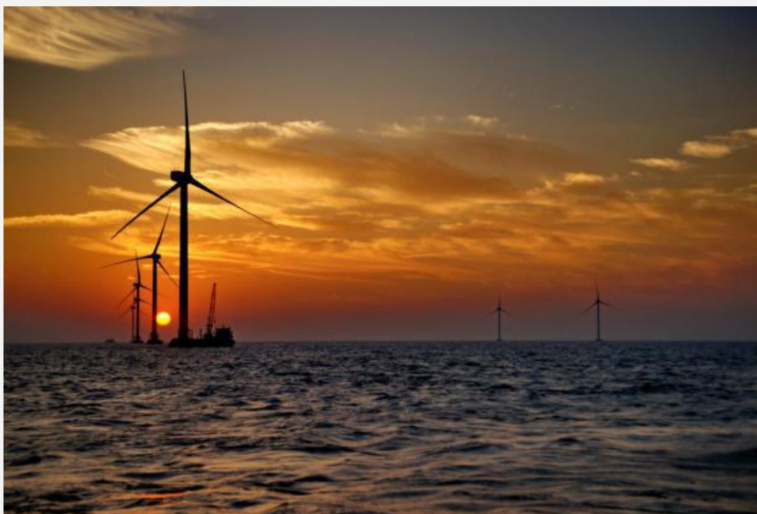
图 10 上海东海大桥海上风电场
