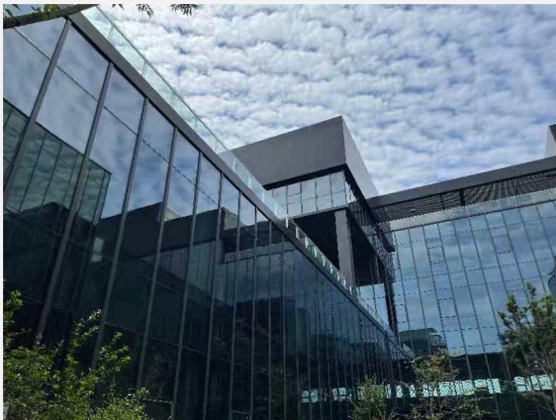
图 9 上海首个薄膜光伏建筑凯盛机器人智能装备研发中心
