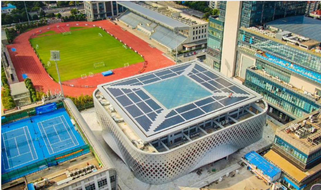
图 7 松江体育馆屋顶光伏发电
