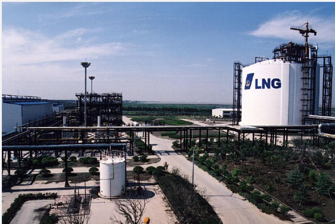
图 11 浦东新区五号沟 LNG 站
