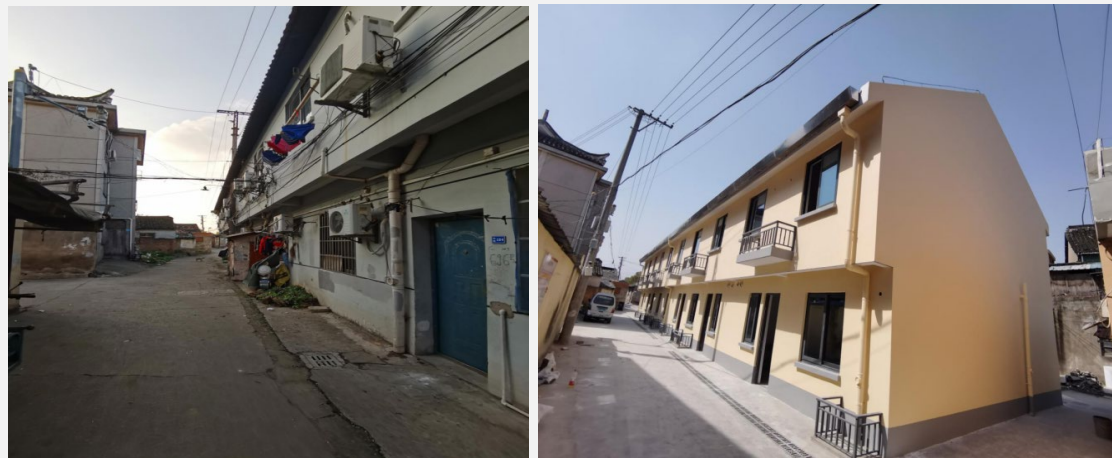
图 38 金汇镇金汇村 696-697 号改造前后
