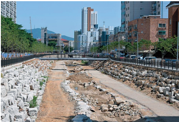
图 2-41 仁川市河道生态修复工程现场
