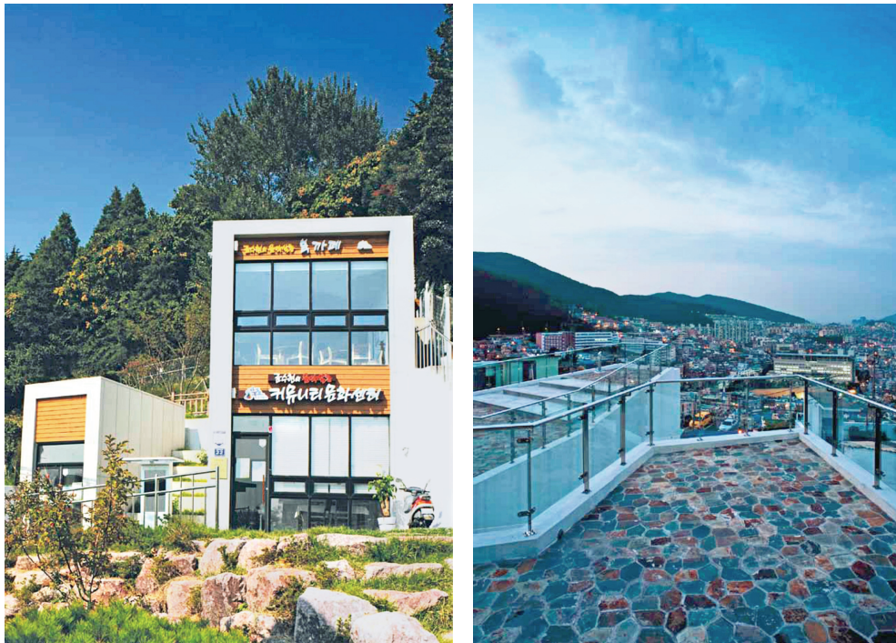
图 3.22 山腹道地区新建的文化设施
